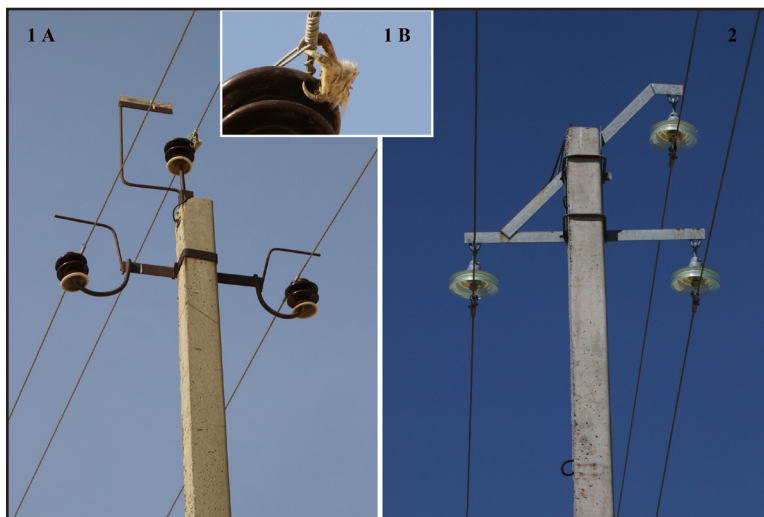
Рис. 2. Траверса ВЛЭ АО «КазТрансГаз» со штыревыми изоляторами – наиболее распространённый и опасный для птиц вариант конструкции – 1А. На верхнем проводе видна лапа филина ( Bubo bubo ), погибшего от поражения электрическим током – 1В. Опоры ВЛЭ АО «КазТрансОйл», оборудованные траверсами «ласточкин хвост» с подвесными тарельчатыми изоляторами, также опасны для крупных хищных птиц и нуждаются в дооборудовании ПЗУ – 2. Фото М. Пестова.
