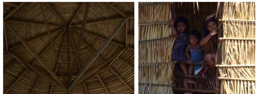
**Figura 2.** Formas de uso da palha-branca para A. cobertura de telhado e B. cobertura de paredes das casas nas comunidades indígenas Deus é amor e São Raimundo na RDS-PP. Fotos: Heloisa Brum.
