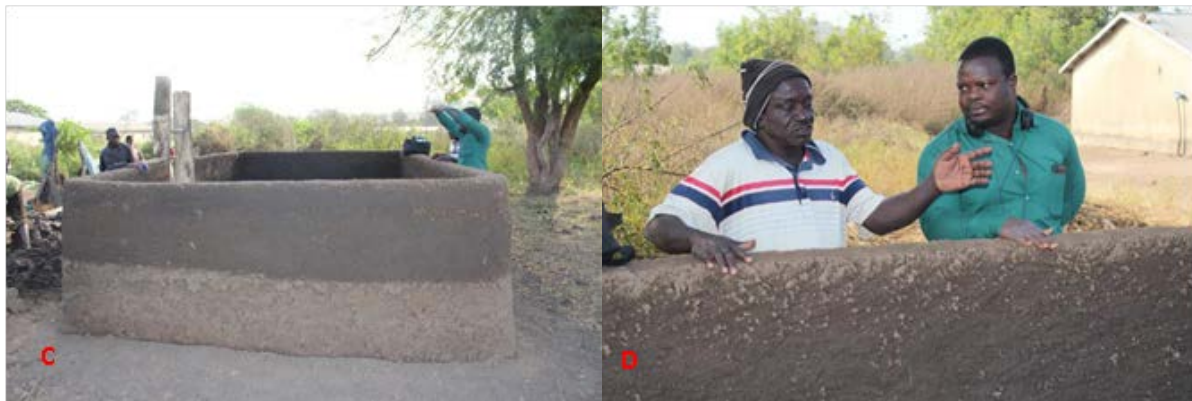
Photo 2: (C) et (D) Montage des murs de la champignonnière avec de la terre battue.
