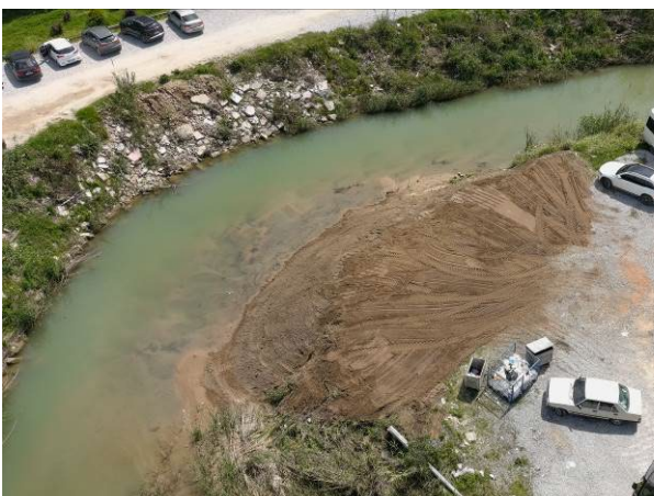
Fotoğraf 11. After Restoration
