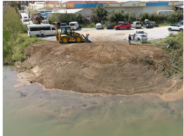
Fotoğraf 10. After Restoration
