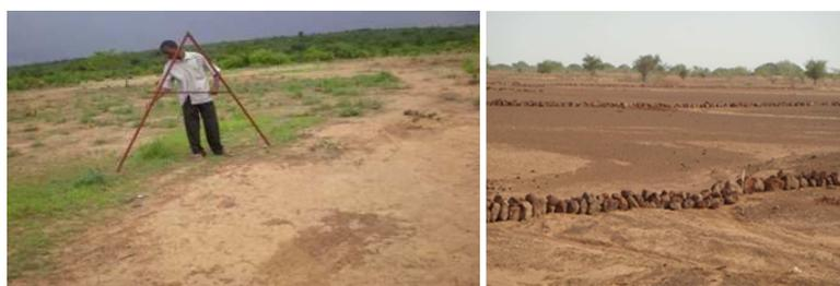
Figure 12 : Prise de courbes de niveau pour l'installation des cordons
